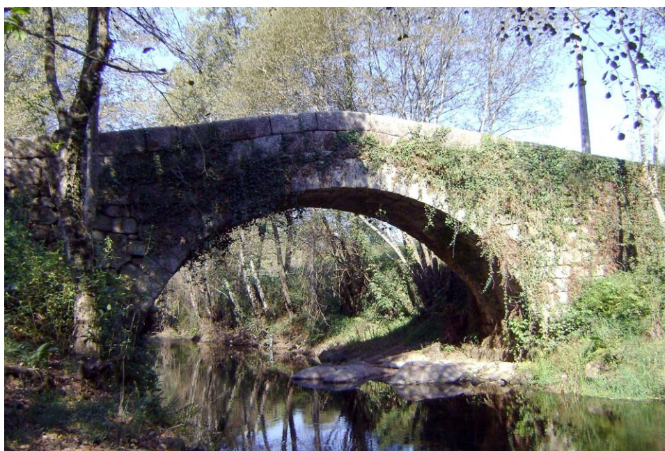
Figura 10: Ponte sobre o rio Vade
