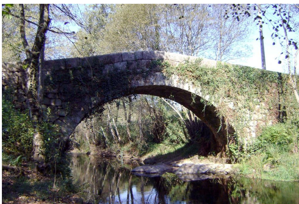
Figura 10: Ponte sobre o rio Vade
