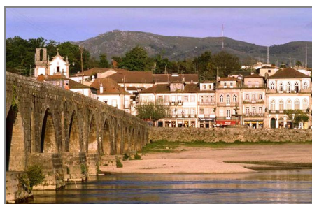
Fig. 7 - Ponte de Lima
